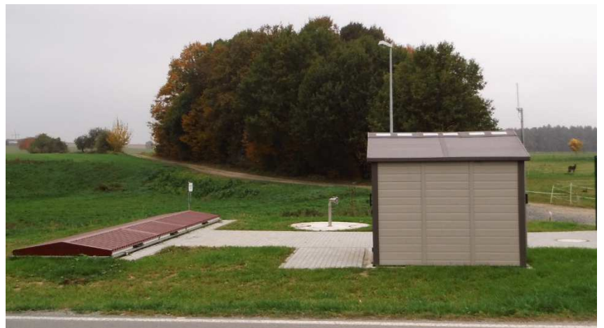
Neubau einer „Kleinen Kläranlage 110EW“, analog der Muster-Kläranlage Großhänchen (Musterbild K-KA Großhänchen)
