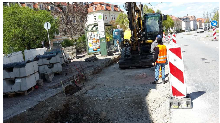
Grundhafter Ausbau Busbucht: Granitpflaster auf Dränbeton
