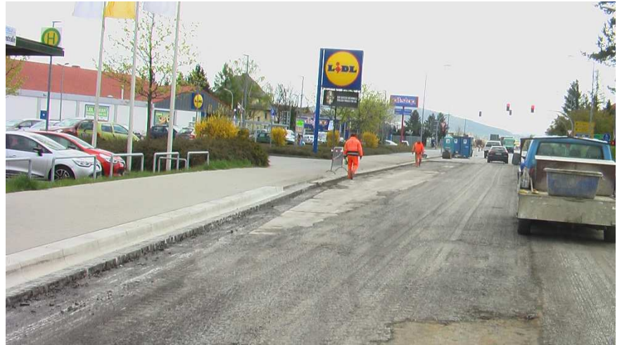
Inspektion nach dem Fräsen
