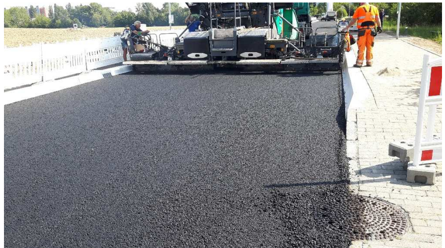
Gehwegsanierung und Bus-Sonderborde
