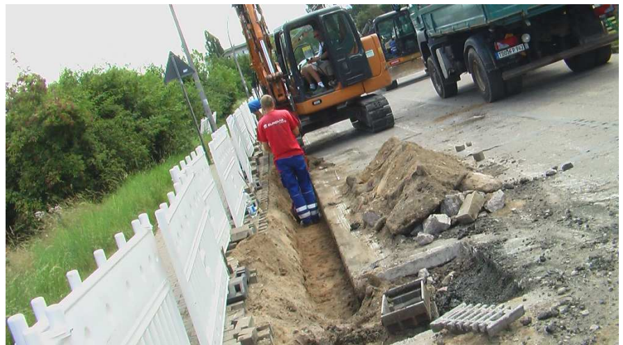
Einzelansanierung / -auswechslung Straßenabläufe
