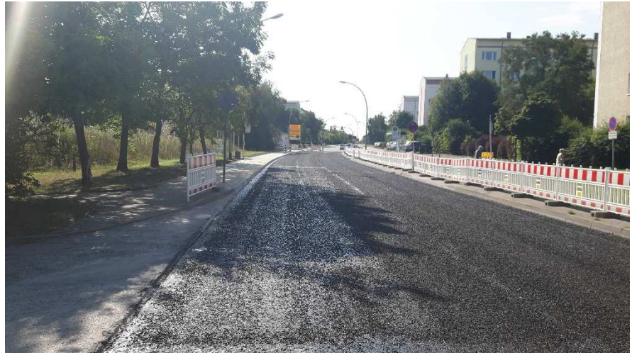
eingebaute Zwischenschicht (SAMI)
