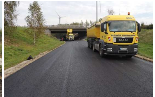
mehrstufiger Rück- und Neubau der Bestandsfahrbahn und der Rampe AST Görlitz
