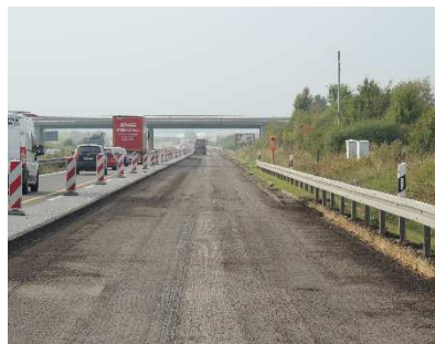
mehrstufiger Rück- und Neubau der Bestandsfahrbahn und der Rampe AST Görlitz
