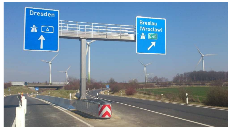
Umbau einer Schilderbrücke und Neubau von passiven Schutzeinrichtungen und der Fahrbahnmarkierung
