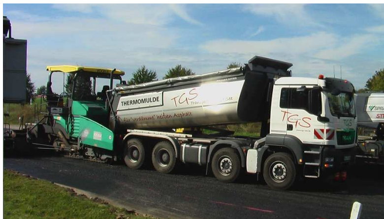
Mischguttransport mit Thermomulde
