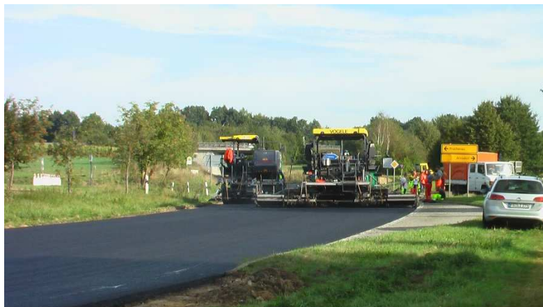
Bindereinbau heiß an heiß mit 2 Fertigern
